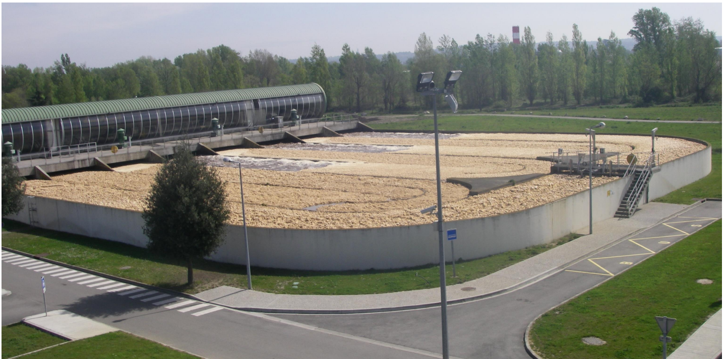
Station de dépollution de 40 000 équivalents habitants située sur la commune de Cugnaux.
